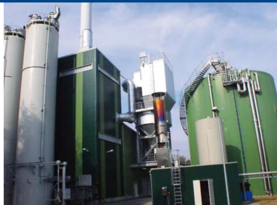
Die Produktion von Stärke, wie hier in Ibbenbüren bei Kröner Stärke, gehört zu den energieintensivsten Verfahren. Dank des maßgeschneiderten URBANA-Konzeptes ist die Energieversorgung der Anlage auf Jahrzehnte absolut sicher kalkuliert.
