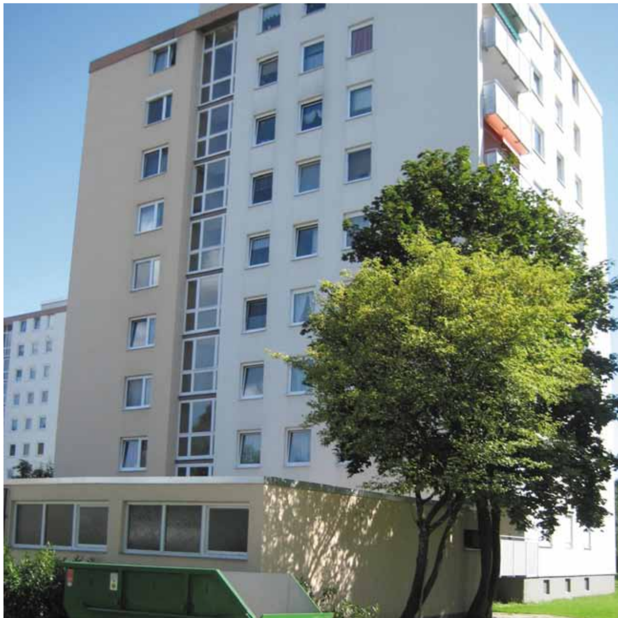
Seit vier Jahrzehnten beliefert URBANA die Wohngebäude in der Ringstraßensiedlung (Raunheim) mit Wärme, nun wird modernisiert. Der größte Teil der produzierten Wärme wird künftig durch eine moderne Holzpelletanlage mit einer Wärmeleistung von 4 Megawatt mit automatischer Beschickung ersetzt. Ergebnis: fast drei Viertel der bisher eingesetzten fossilen Energieträger können durch klimafreundliche, erneuerbare Energien ersetzt werden.
